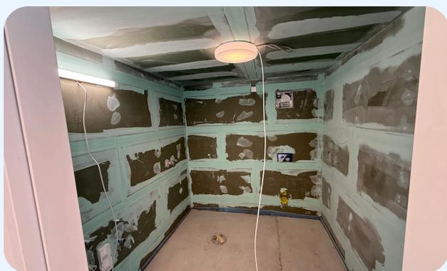
Im Inneren des Gebäudes sind derzeit vor allem die Trockenbauer aktiv. Sie verkleiden die Wände und Decken, was den Räumen sichtbare Struktur gibt und auch um die Räume für die nächsten Arbeitsschritte vorzubereiten. Die Elektrik und Wasserleitungen sind bereits verlegt, und auch die Monteure der Lüftungsanlagen sind vor Ort und arbeiten am Aufbau der Systeme.
